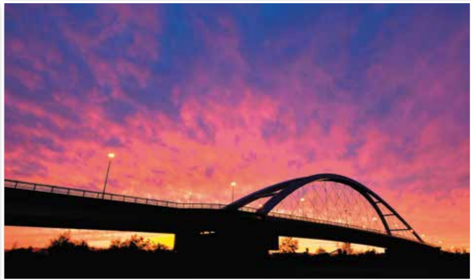
石狩川に架かる永山橋(9月 旭川市)
